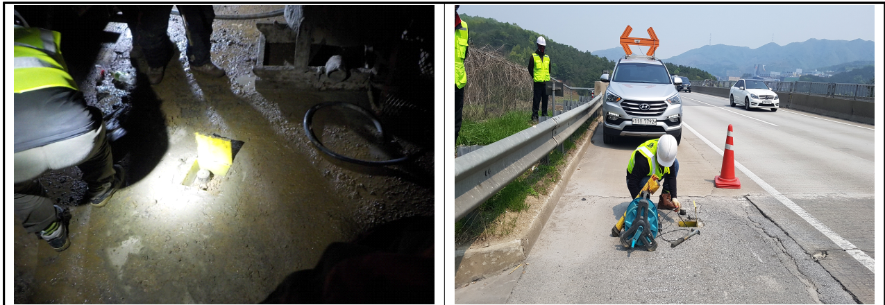
【사진 3.10】 지중경사계 설치 및 계측(계속)
