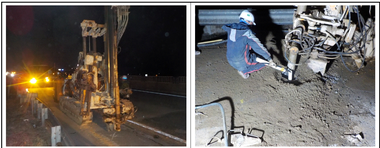
【사진 3.10】 지중경사계 설치 및 계측
