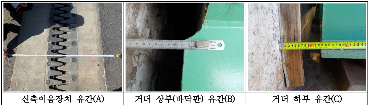
【사진 3.14】 신축이음 유간 측정방법
