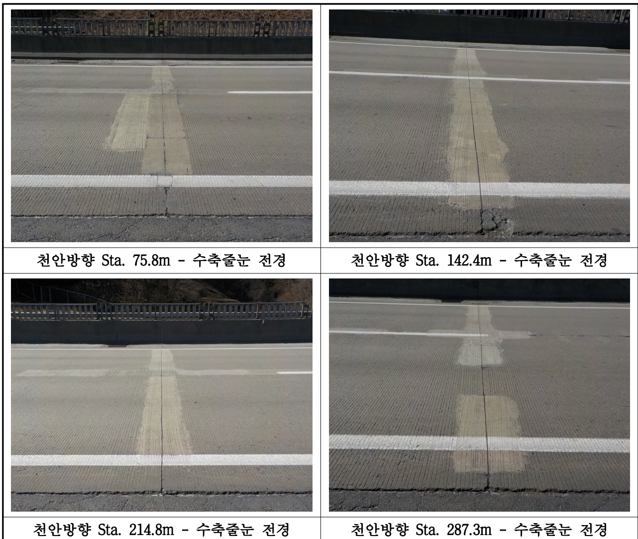
【사진 3.2】 수축줄눈 전경
