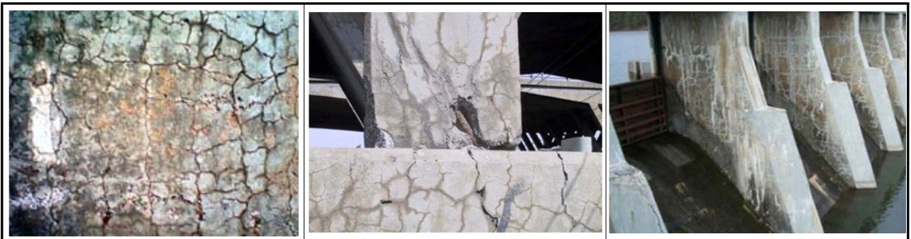
【사진 3.5】알칼리 골재반응에 의한 손상 예시
