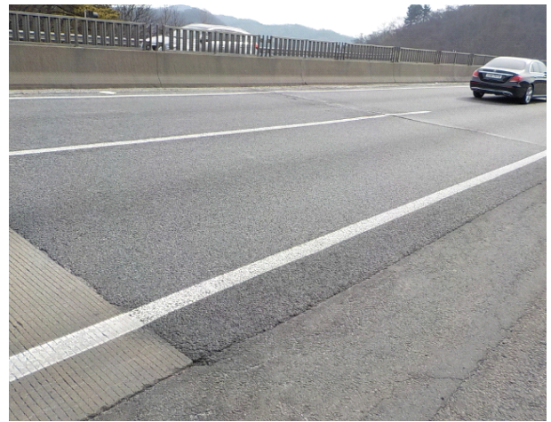
논산방향 시점측 접속포장 전경
